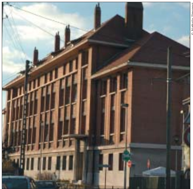
Les Prévoyants : vue d'ensemble.
