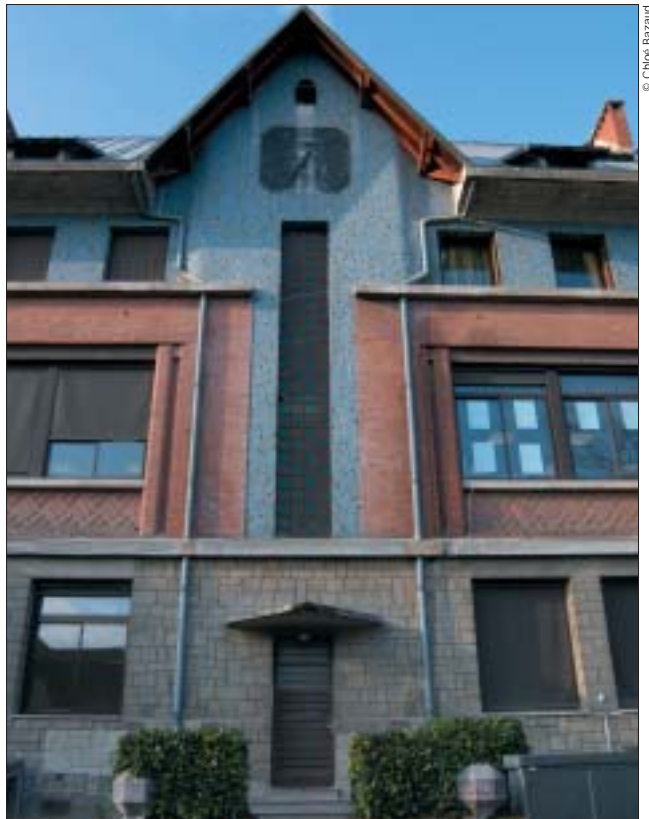
Trois niveaux, trois couleurs, trois matériaux.
