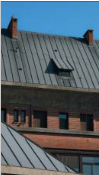
Détail de l'élévation sur cour.
